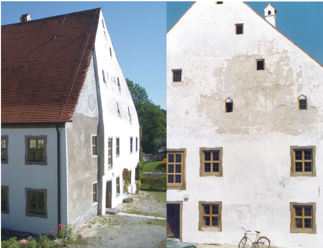
Bild 7: Aufnahme der süd-westorientierten Fassade des Valleyer Schosses von der Seite und von vorne. Der geneigte Bereich ist deutlich geschädigt.
