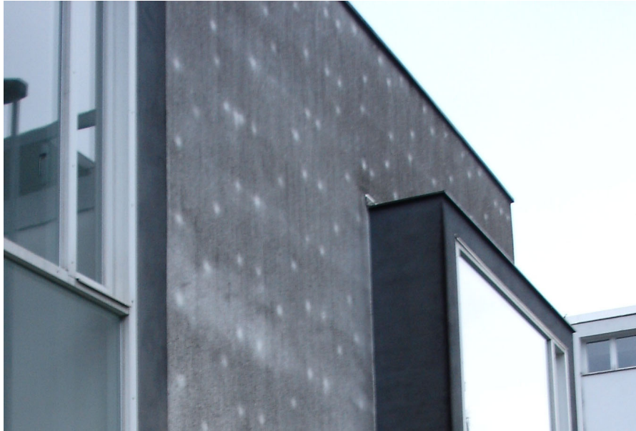
Bild 11: Das in [10] als Leopard-Effekt bezeichnete Muster auf dieser Gebäudefassade ist ein eindeutiges Zeichen für mikrobiellen Bewuchs aufgrund von Tauwasserbildung.
