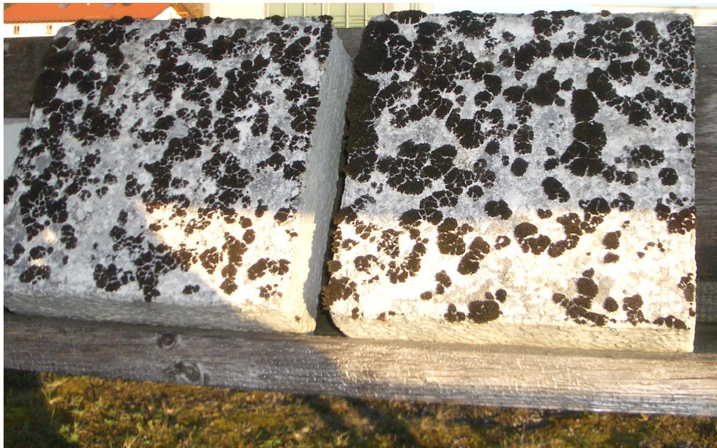
Bild 9: Mit einer Vertikalneigung von ca. 30° nach Westen orientierte WDVS-Prüfkörper nach einer Expositionszeit von zwölf Jahren. Die deutlich höhere Niederschlagsbeanspruchung durch die Neigung hat zu einer Zerstörung des Deckputzes und in der Folge zu einem starken Moosbewuchs auf der Oberfläche geführt.
